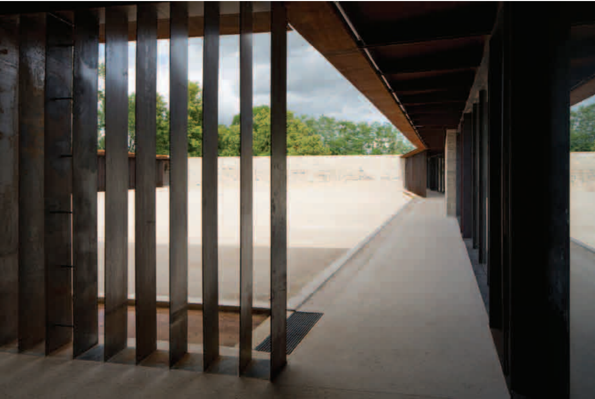
La cuisine, centre d'art et de design, château de Nègrepelisse, juin 2014. Architectes : RCR. © Yohann Gozard.
